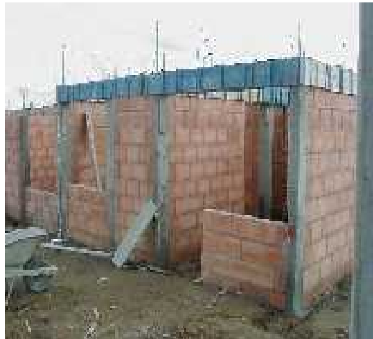
Encofrados en uso
