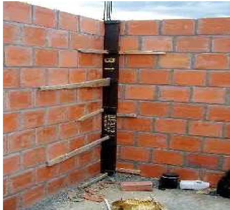
Encofrados en uso
