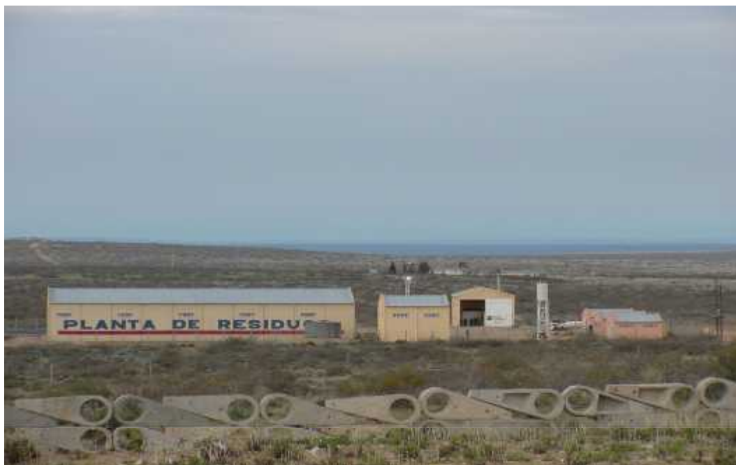
Vista panorámica de la Planta
