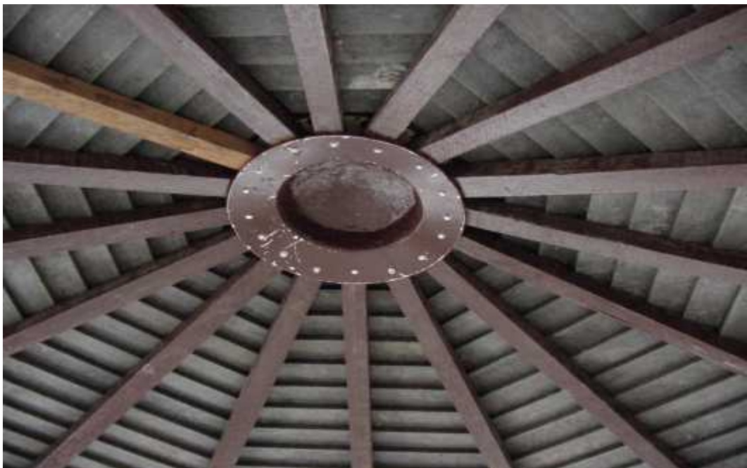
Cubierta de kiosco - interior
