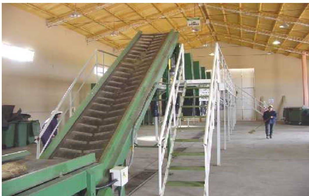
Vista interior de la Planta
