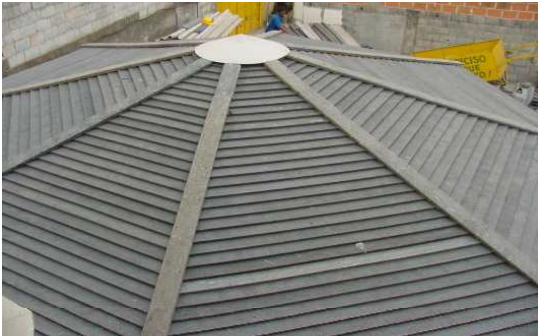
Cubierta de kiosco - exterior
