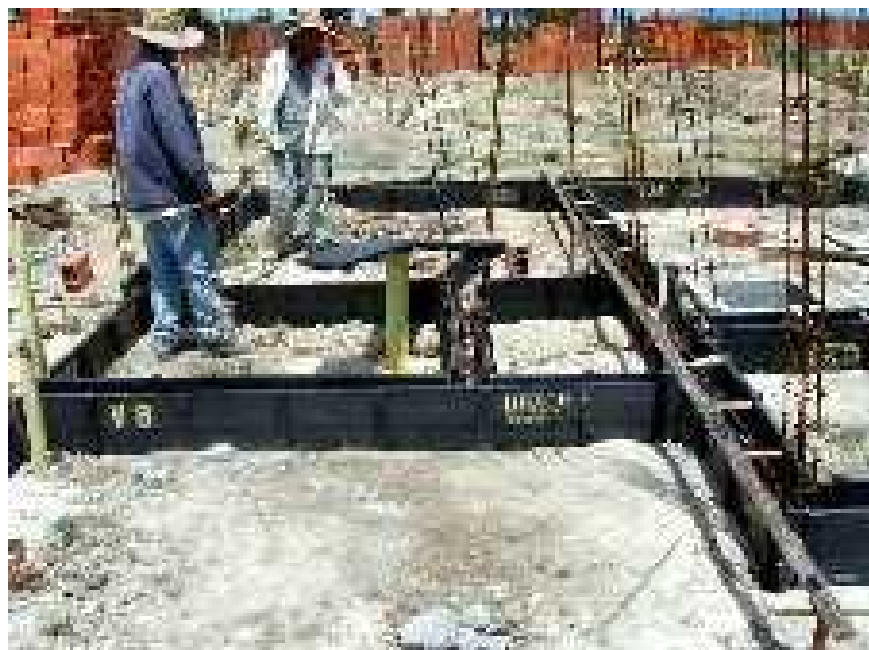
Encofrados en uso
